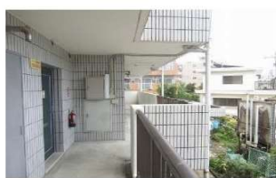
廊下・ドア周り
