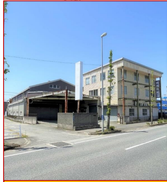
北側土地(東側から撮影)
